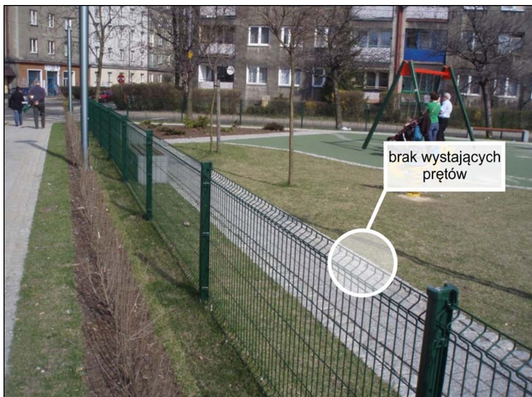
Rys.12 Projektowany typ ogrodzenia panelowego (zaznaczono miejsca gdzie absolutnie nie mogą występować pionowe pręty).
