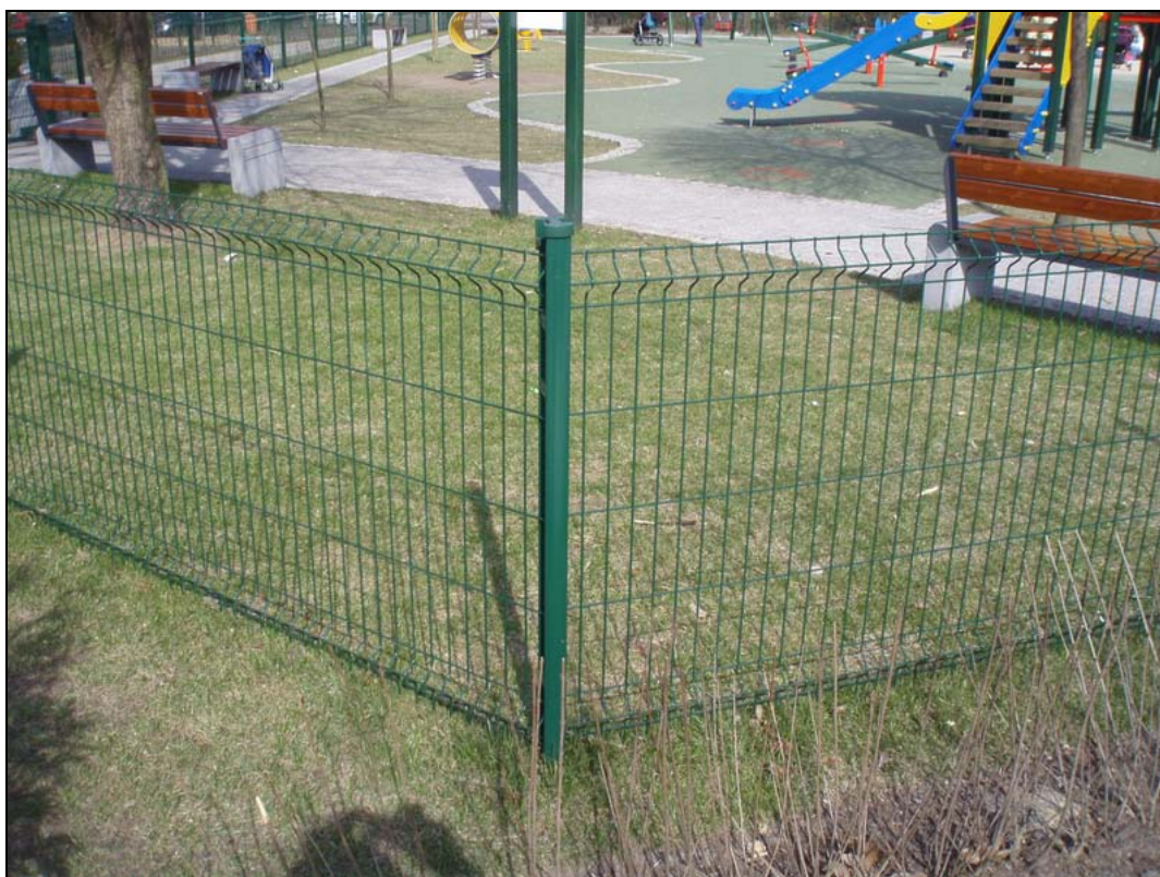
Rys.11 Projektowany typ ogrodzenia panelowego.
