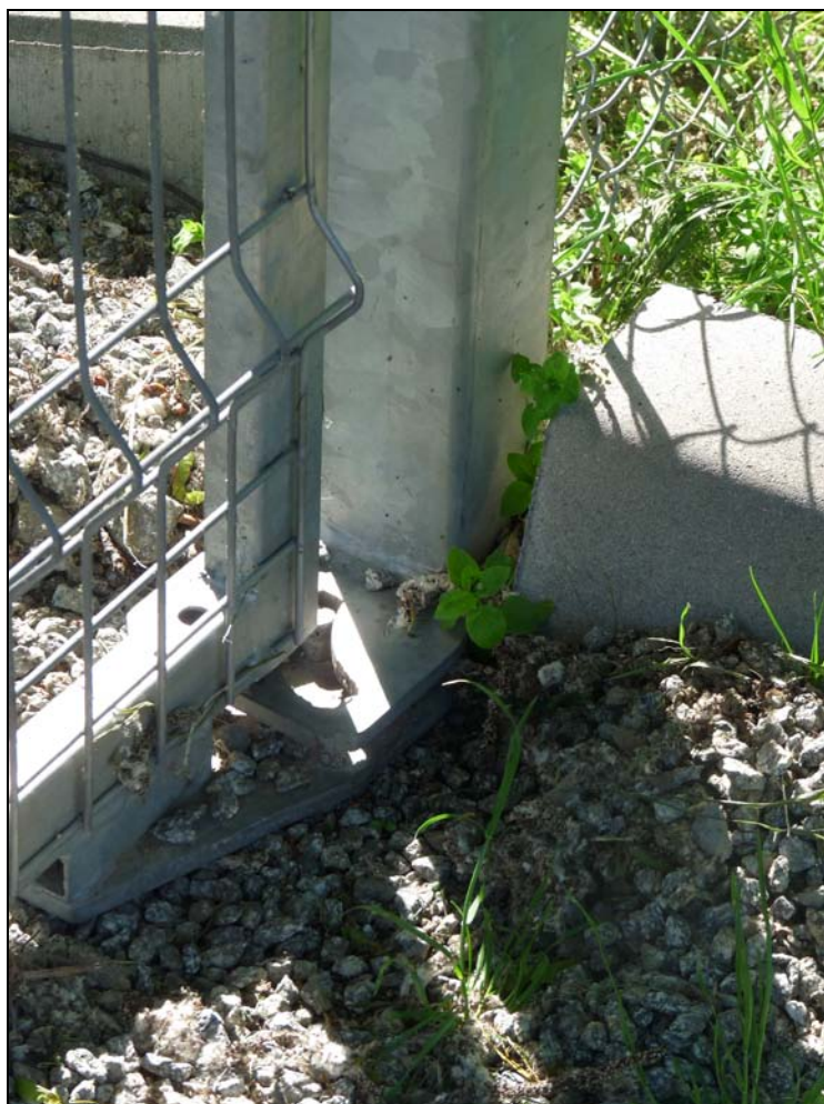
Rys. 13 Proponowany system samozamykacza w furtce. Widoczny dolny zawias większego skrzydła furtki, który pozwala na bezpieczne samozamknięcie skrzydła pod naporem pionowym własnego ciężaru. (tu na ilustracji tylko ocynkowana, ma być malowana proszkowo)
